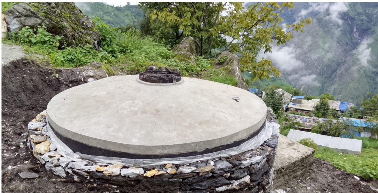
निर्माणाधिक चिलढुङ्गा खानेपानी तथा सरसफाइ योजना अपिहिमाल ४
