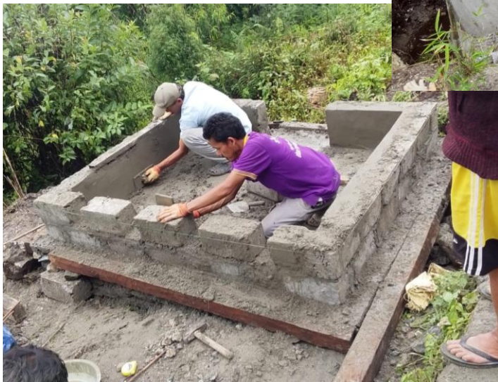
ईन्सिनेटर निर्माण हुदै
